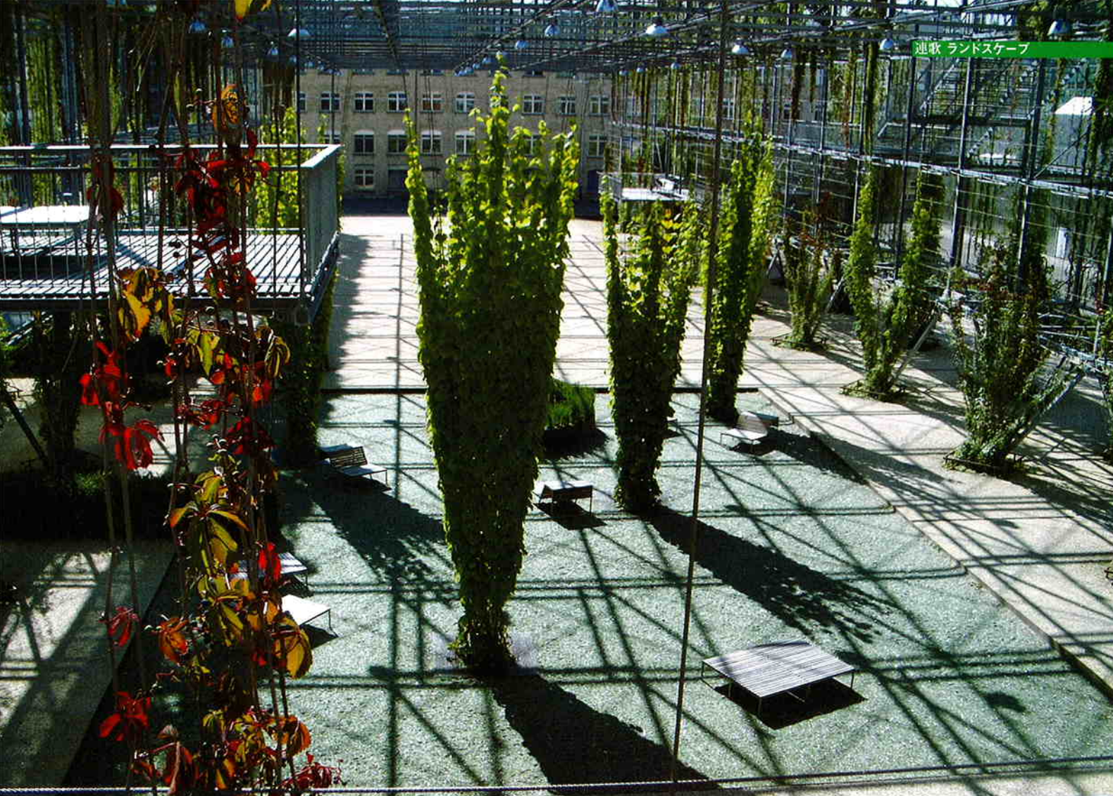
ワインボトル再生品のガラスの角を落とした美しい豆砂利を敷き込んだサンクンガーデン。巨大なメタル・ストラクチャー。時間の経過と共に登攀植物がストラクチャーを覆っていく。
