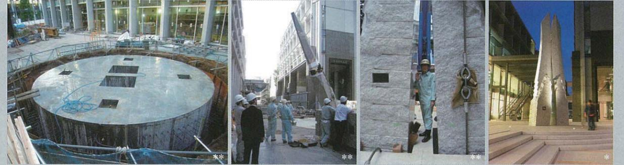
巨石のモニュメント「翔」は、「東京スカイツリー」のデザイン監修者でもある彫刻家・澄川喜一氏の作品で、石材は瀬戸内海黒髪島産、長さ10mの伸びやかで美しい原石を最大限に生かしながら年月を掛けられて構想・制作された。キャンパスの正面・中央に巨石モニュメントが座る構成とした。手を合わせる祈りの姿、天に飛翔する姿を、古来の「鳥居」をモチーフにされ、抽象化されて制作された。左／彫刻基礎の150㎡のマス・コンクリート基礎。左中／130トンクレーンで、一基20トンの彫刻石を釣りこむ。右中／仮据えされた「翔」の間に立つ澄川氏。右／「翔」の夜景。存在感の増すライトアップ
